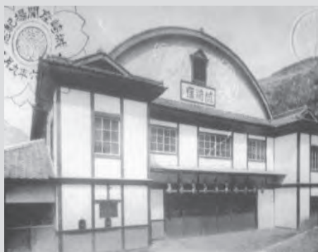
上間藤に建てられた城崎座。現在は解体されている。
