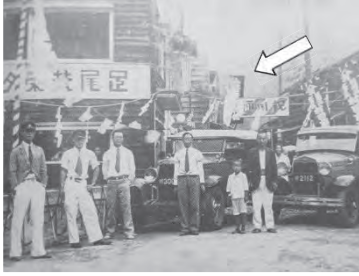
足尾共栄と書いてある建物の奥が小野崎写真館
