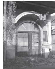
アーチの庇が付いた扉
