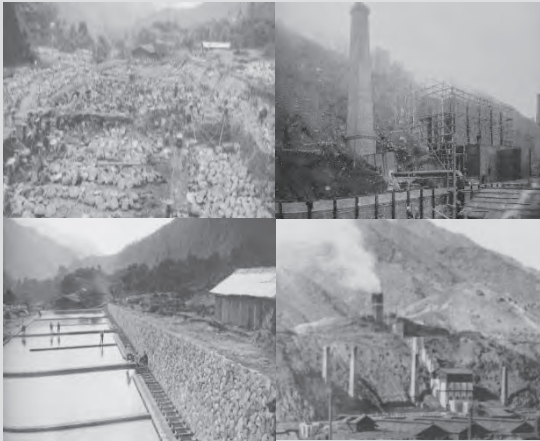
(右上)建設中の脱硫塔 (右下)脱硫塔完成 (左上)建設中の沈殿池 (左下)沈殿池完成
