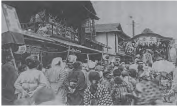
お祭りの様子。左側が川本食堂。現在、ベランダはなくなっている
