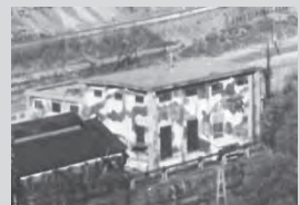
新梨子油力発電所。迷彩柄が施されている
